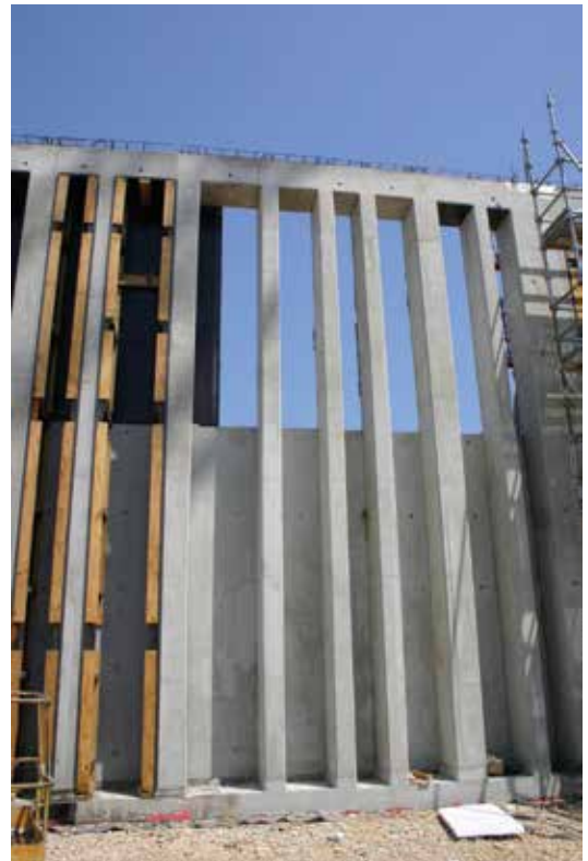
Banche Omega-Meccano dimensionnée pour reprise 15 tonnes/m 2 - Vinci Hôpital Nord Marseille / Lycée Louis Armand
