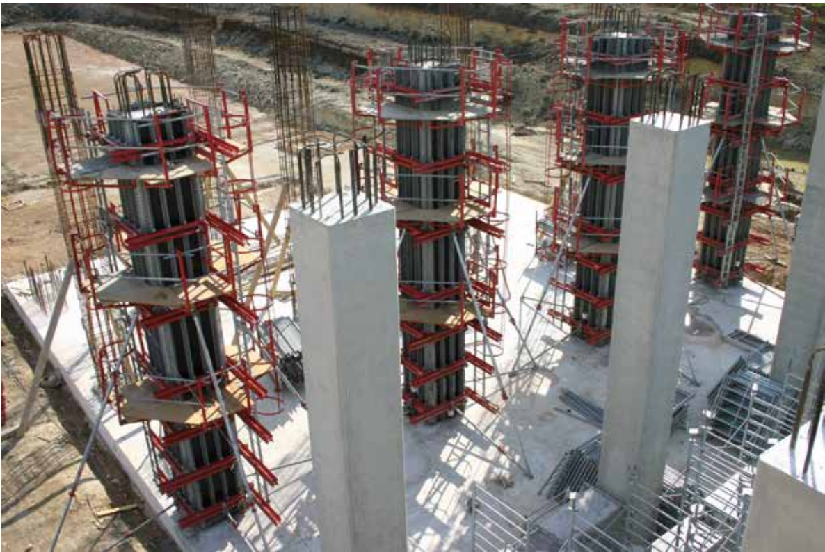
Coffrage de Poteaux : Solution Banche midi+ avec arrêts / Poteaux Meccano Omega
