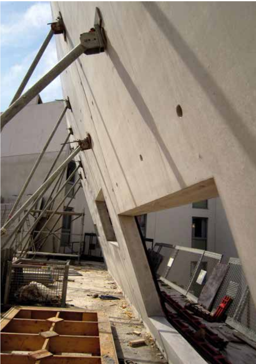
LEON GROSSE - FRAC Marseille : Châssis roulant de reprise Meccano / Banche Midi + inclinée sur châssis Angle incliné, variable en Omega Meccano
