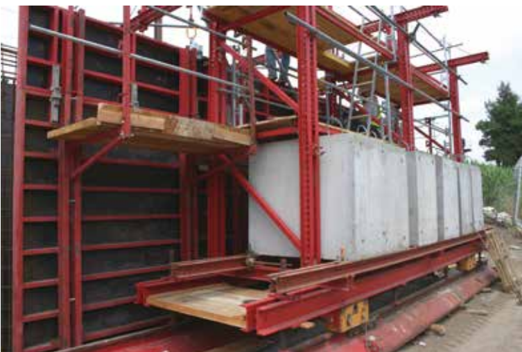
VINCI - Marseille : Banches Midi + suspendues sur portique Meccano - outil roulant sur voie de grue
