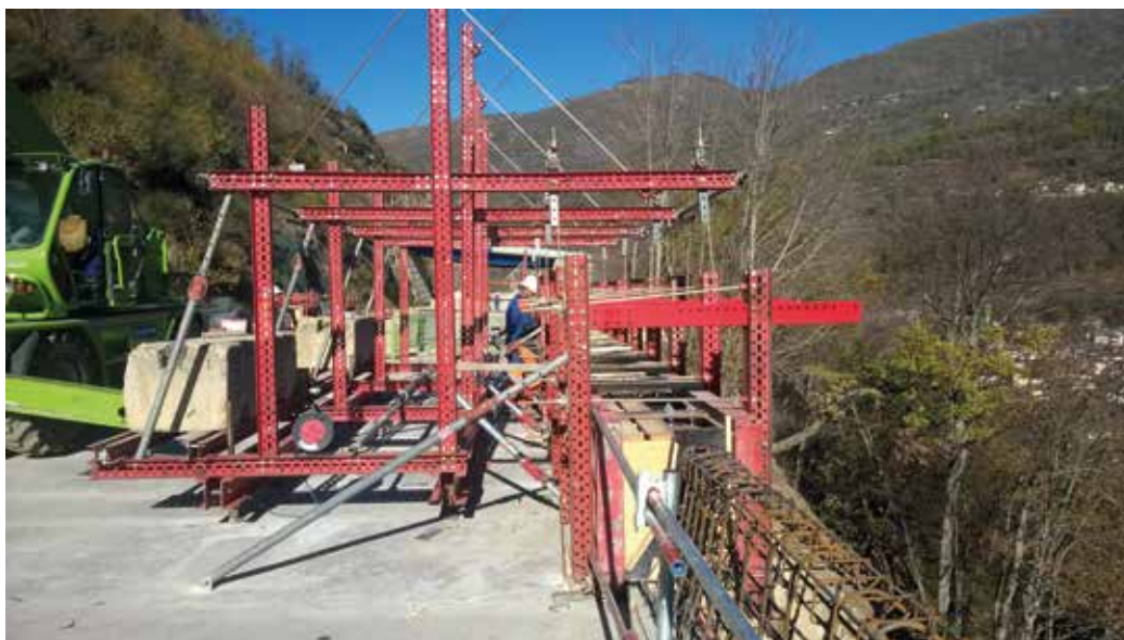
Portique roulant pour coffrage Bn – Joes panneaux Midi et menuiserie Coffrage du Vallon
