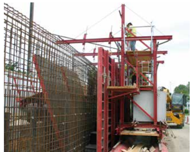
VINCI - Marseille : Banches Midi + suspendues sur portique Meccano - outil roulant sur voie de grue
