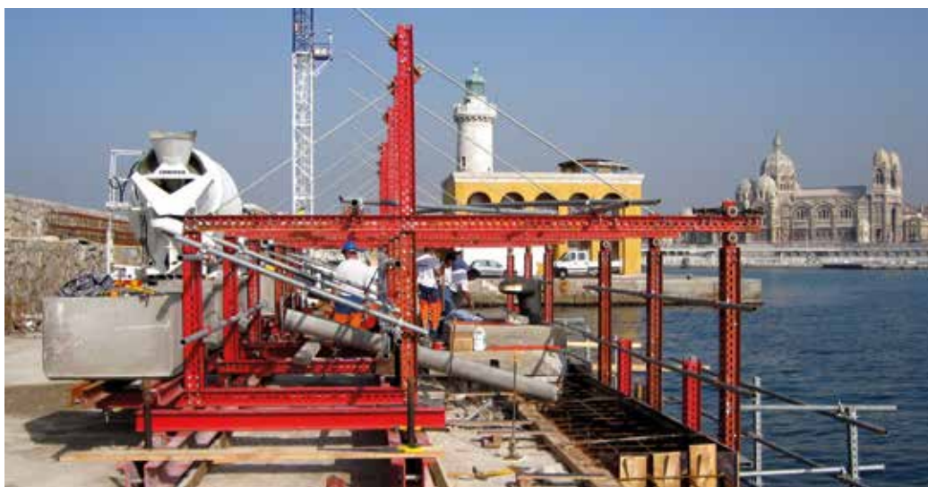
Portique roulant pour extension du quai J4 - Marseille
