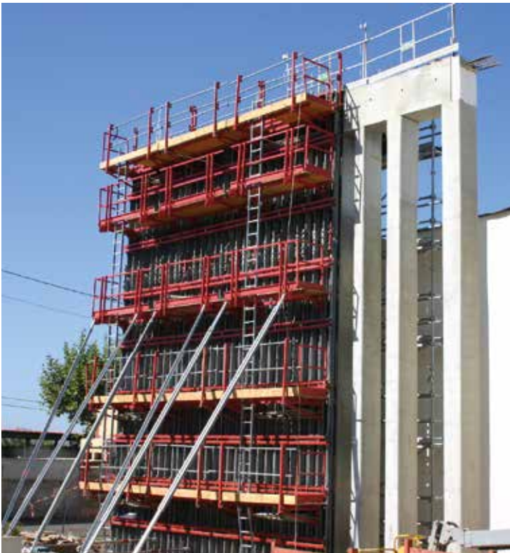
Banche Omega-Meccano dimensionnée pour reprise 15 tonnes/m 2 - Vinci Hôpital Nord Marseille / Lycée Louis Armand
