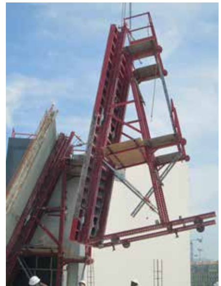
LEON GROSSE - FRAC Marseille : Châssis roulant de reprise Meccano / Banche Midi + inclinée sur châssis Angle incliné, variable en Omega Meccano
