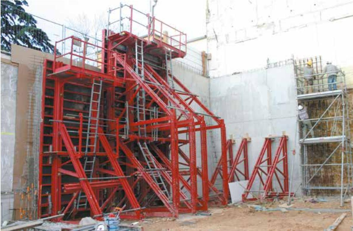
**GAGNERAUD CONSTRUCTION** – Marseille – Coffrage une face hauteur variable et utilisation de fermes indépendantes pour butonner les voiles.
