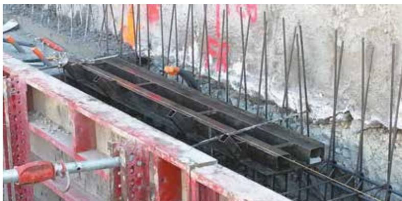
Détail et positionnement des ancrages sur une banche Midi+ 2m40
