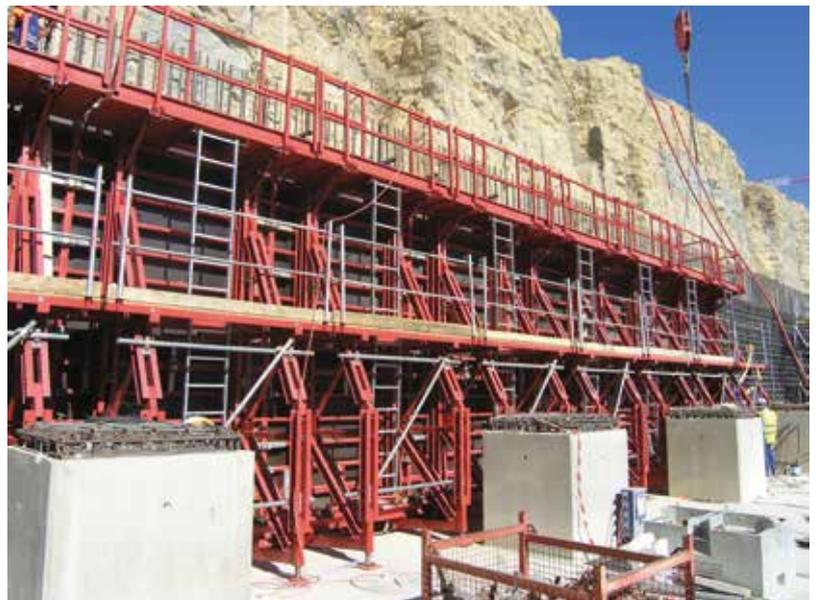
ITER - Développement et fabrication de fermes spécifiques pour le chantier.
