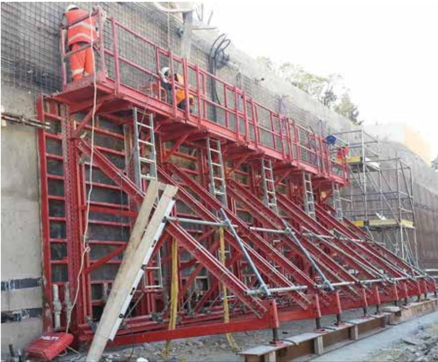
**CHANTIERS MODERNES** - Aix en Provence - Première levée une face hauteur 3m90 et seconde levée sur console barrage
