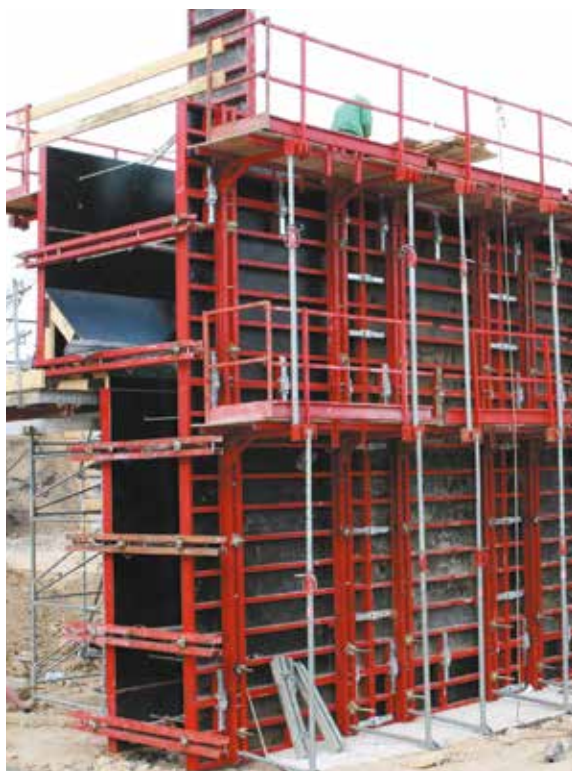
Coffrages de culées avec goussets intégrés
