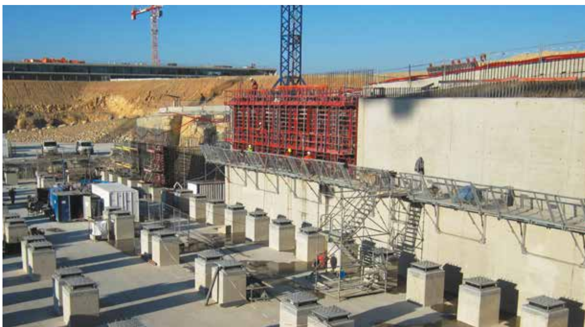
VINCI – Iter – Coffrages des Voiles de l'enceinte du Tokamak
