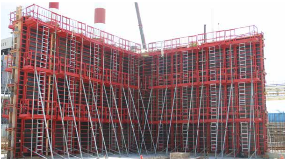
CARI - RAZEL BEC -hauteur 9m00 - Centrale EDF de Martigues
