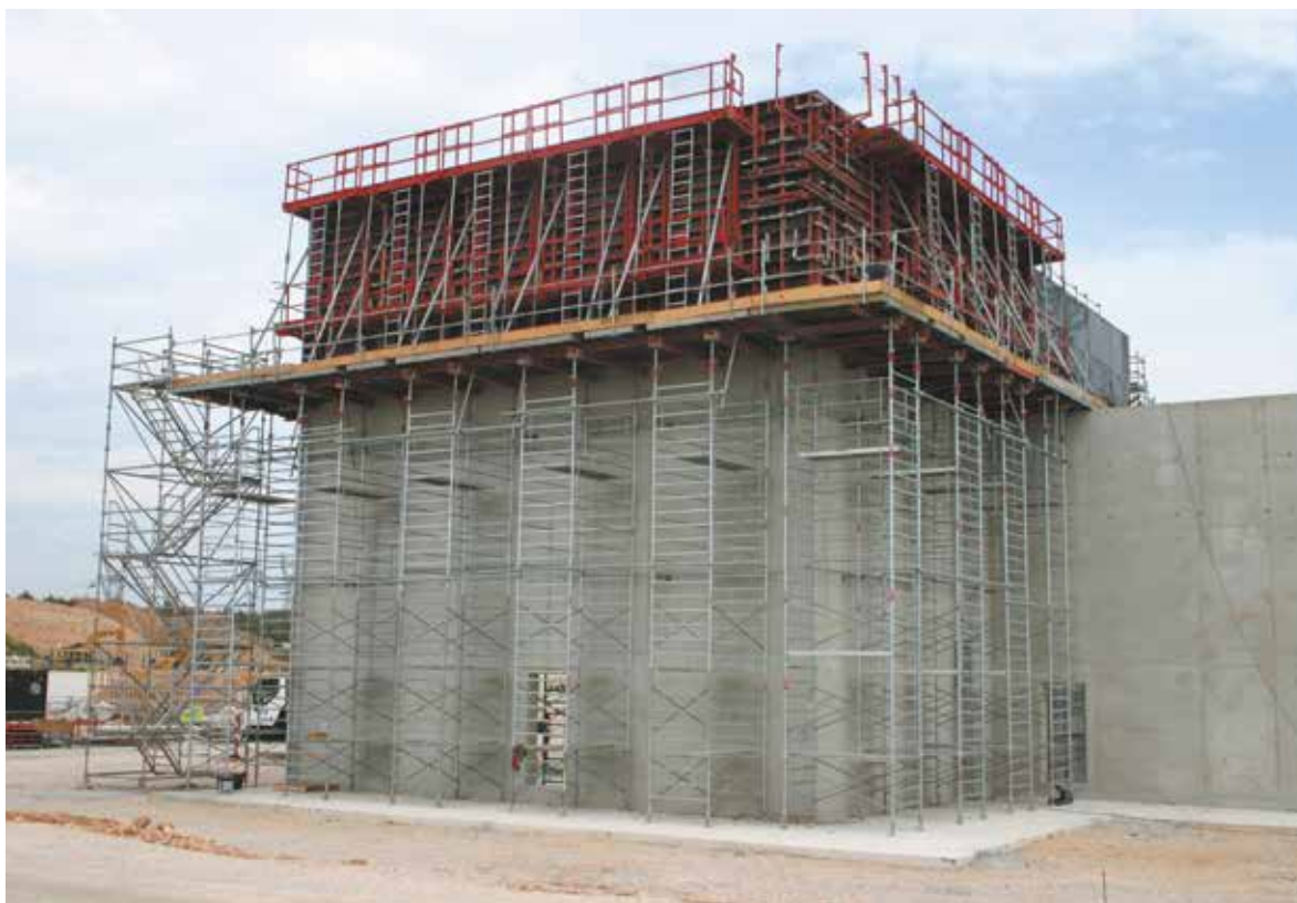
CARI – EDF Martigues – Levée hauteur 4m50 sur plateaux support de banche et étaielement
