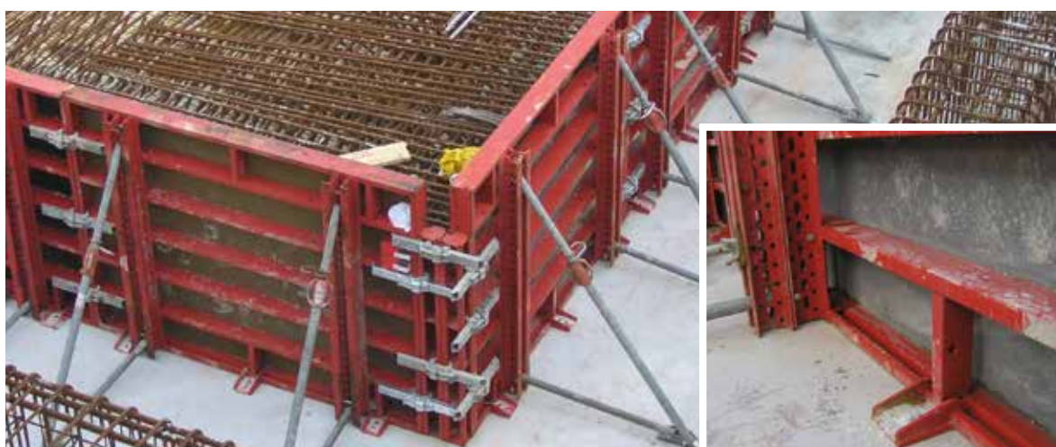
Coffrage des radiers du Mucem. Sous-hausses de banches Midi +. Hauteur 1m80 en configuration une face avec sabots et étais TP.
