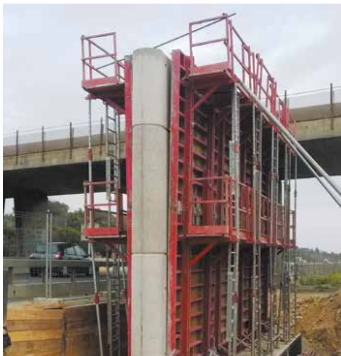
EIFFAGE TP A9 – Pile matricée et about demi-rond
