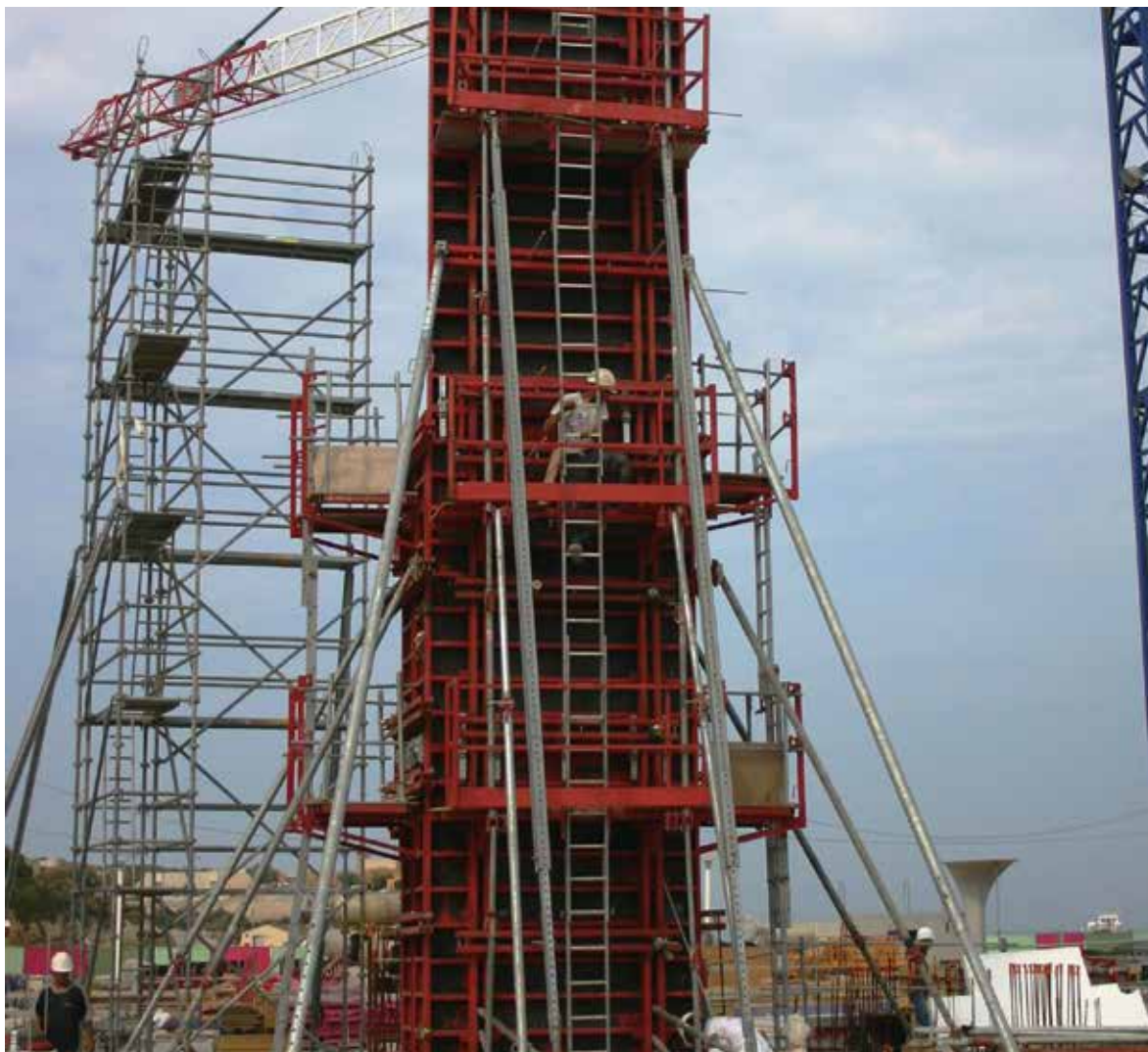
VINCI - Coffrage des piles de la passerelle du Mucem – Hauteur 12 m.
