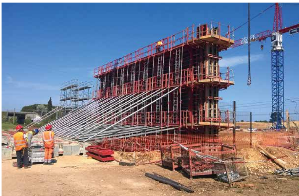
VINCI – Doublement de l'A9 - Ouvrage 1045 B Coffrage de pile hauteur 12m60 avec about demi-rond
