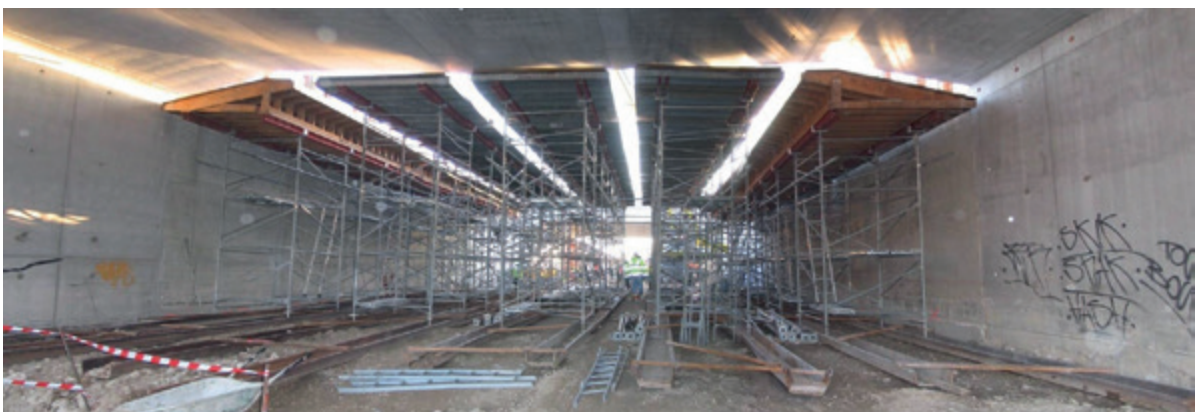
CAMPENON – Palée d'étalement à ripper – Échangeur Florian –Marseille
