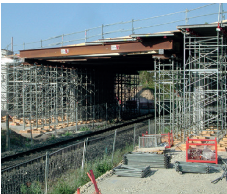
NGE - Franchissement sur voie SNCF PN116 - Bouc-bel-Air
