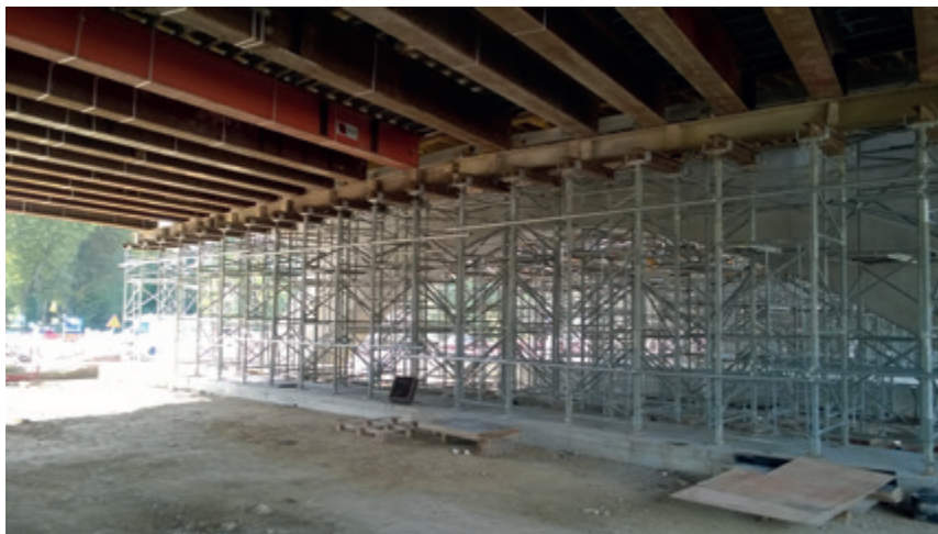
Détail d'un franchissement de l'OA2
