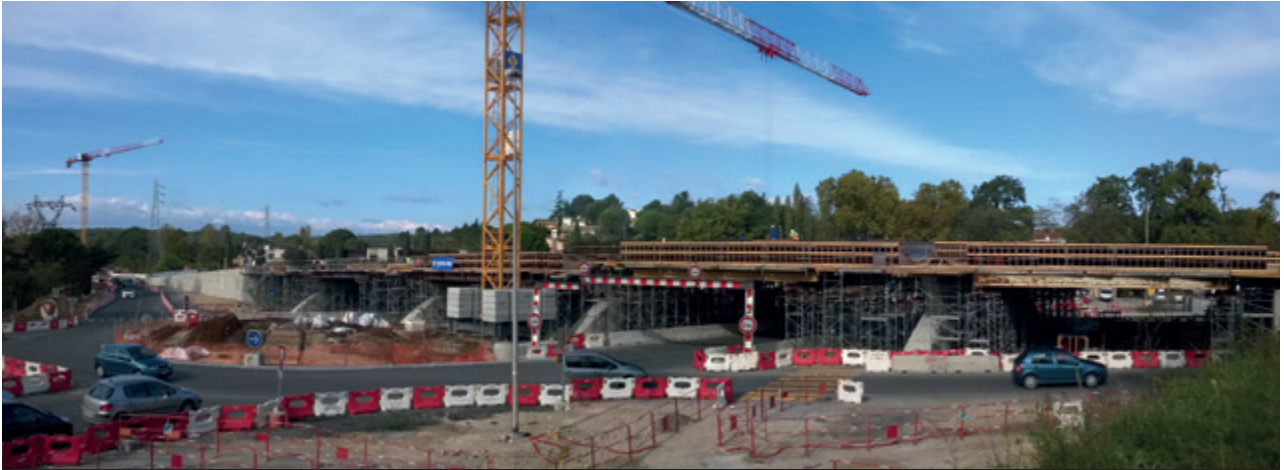
RAZEL BEC – Étalement d'un double tablier, longueur 100 m, avec 4 passes charretières OA2 - RD65 - Montpellier
