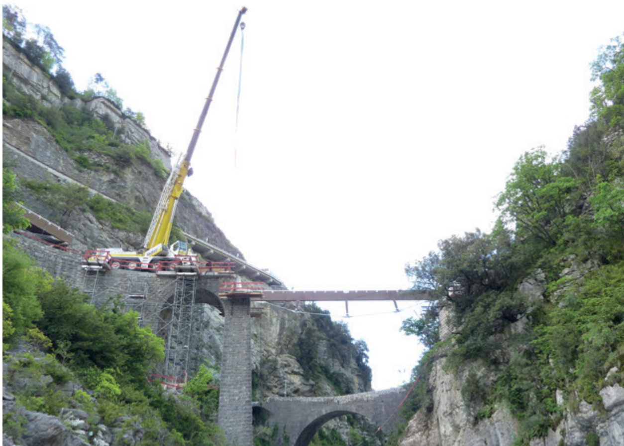
VINCI Côte d'azur - Étalement d'une grue mobile de 40 tonnes - Ilonse
