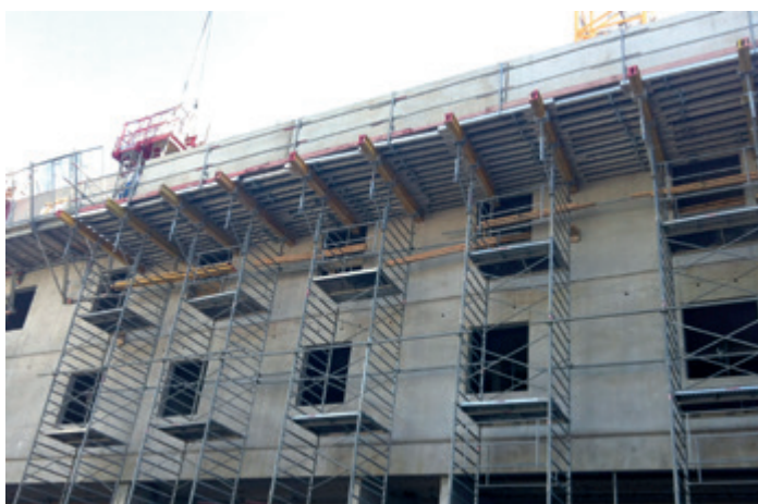
BEC CONSTRUCTION – Clinique de Sète
