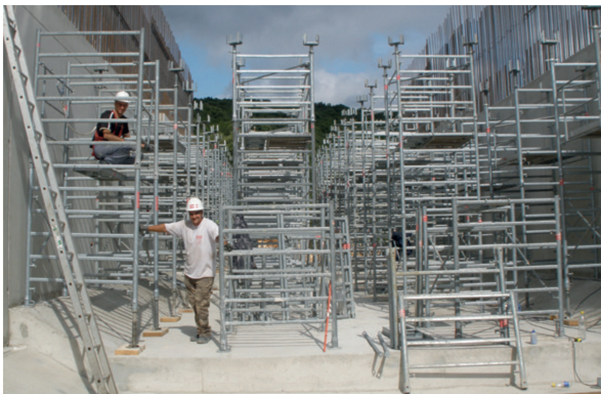
RAZEL BEC - Tour Échelle en configuration TP : Pont Cadre - Montpellier
