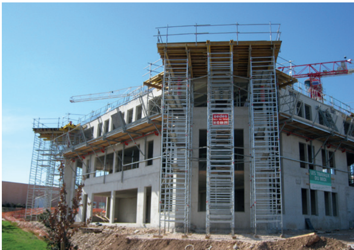
TRAVAUX DU MIDI – Étalement de casquettes béton en porte à faux – La Duranne
