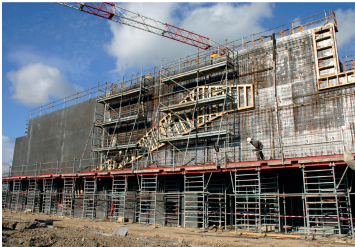
BEC - Tour Échelle en configuration platelage support de banches - Z5 Les Milles
