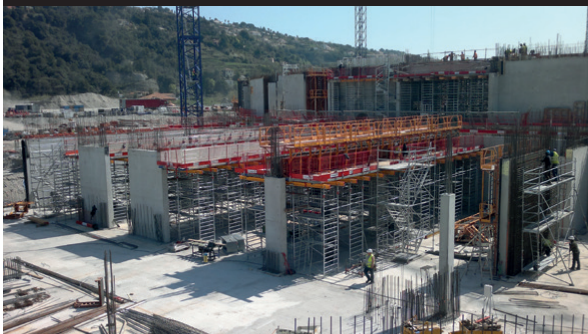
VINCI - Stade de Nice - 1300 tonnes d'étalement mis en œuvre
