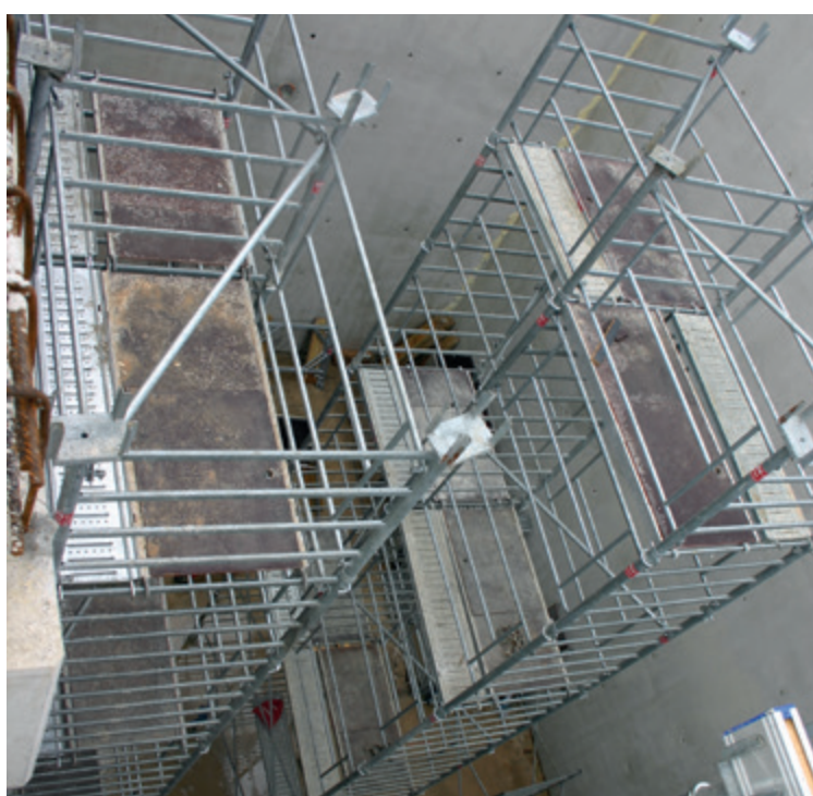
VINCI CÔTE D'AZUR - Tour échelle en configuration grande hauteur - STEP de Cannes
