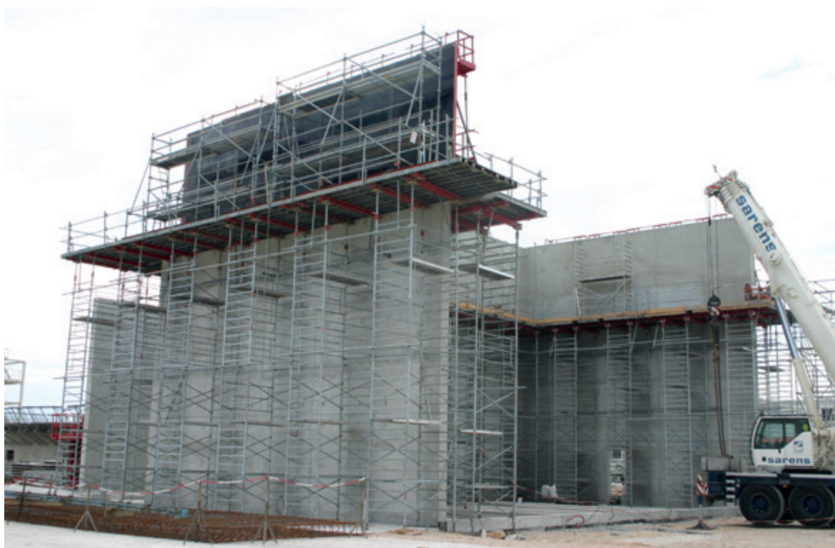
RAZEL BEC – Étalement support de banches – Centrale EDF Martigues
