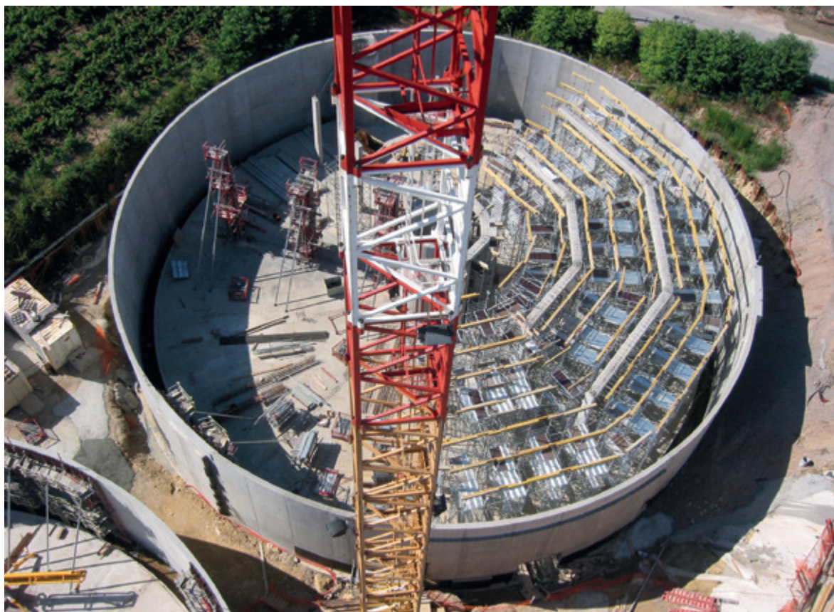
Étalement pour prédalles – STEP de Montpellier
