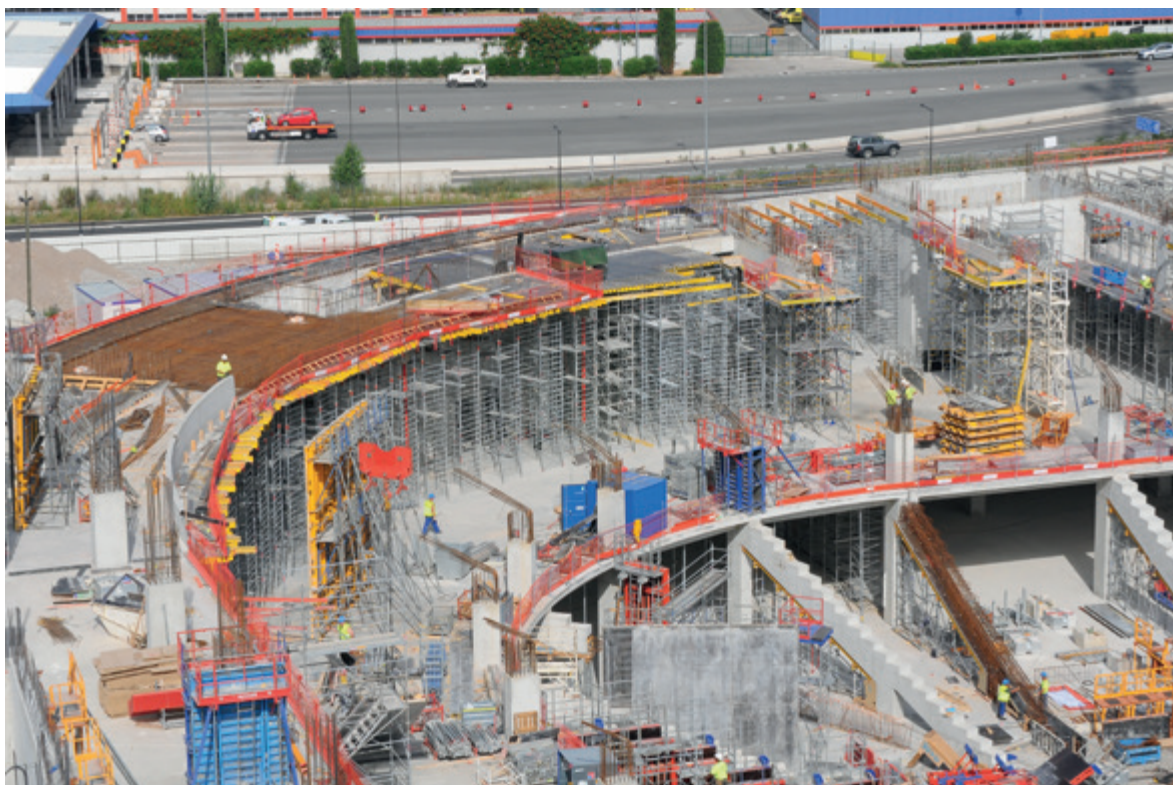
VINCI - Stade de Nice - 1300 tonnes d'étalement mis en œuvre
