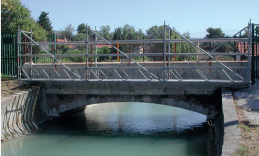
Franchissement sur canal de Provence
