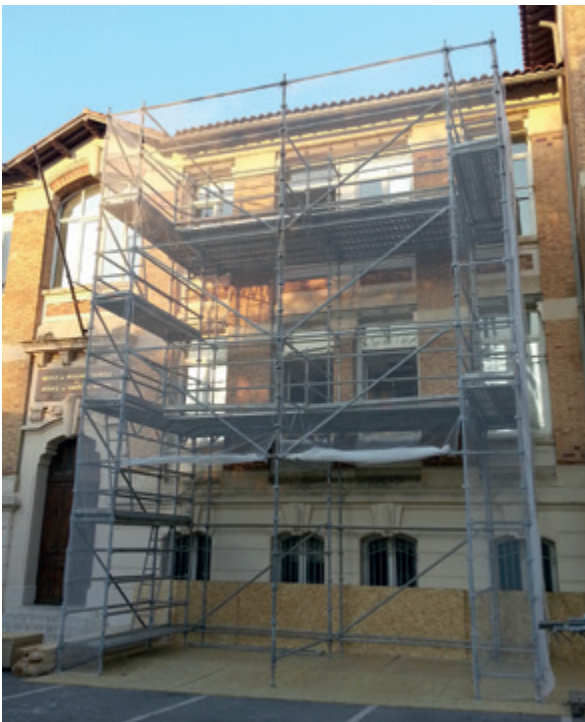
LEON GROSSE - Marseille Structure pour évacuation matériaux
