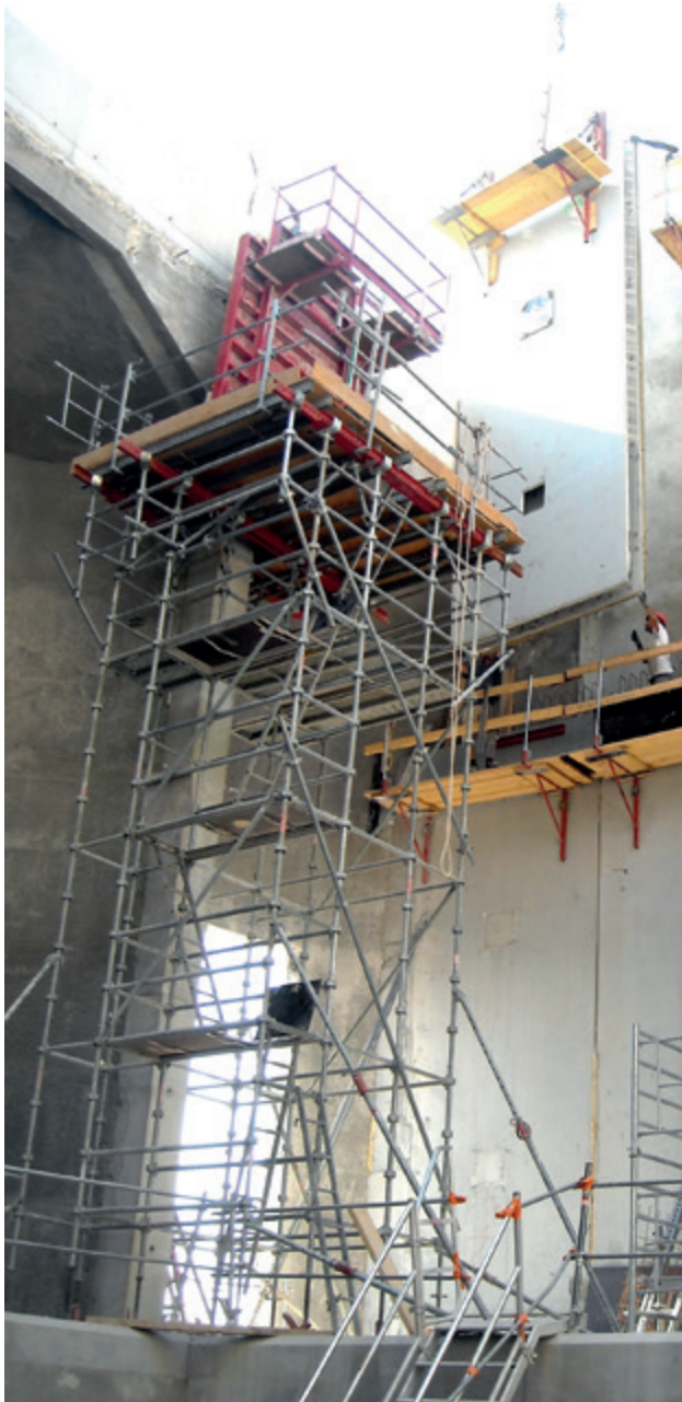
LEON GROSSE - Le Silo - Marseille. Structure multi-directionnelle avec plateau support de banche
