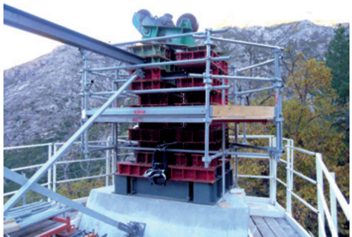
Echafaudage spécifique sur pile d'ouvrage - Bocognano - Corse
